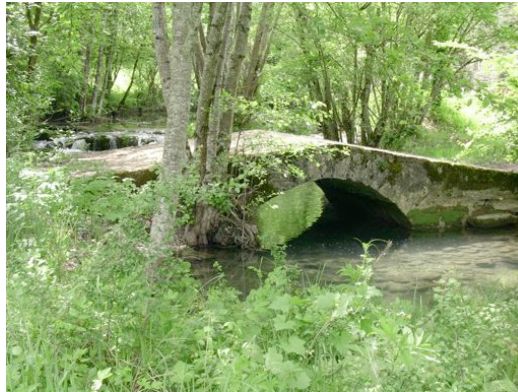
35 ème jour : Pont sur la Rauze 35 th day: Bridge over the Rauze creek
